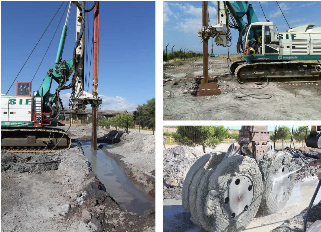
Figura 3.9: fasi di realizzazione dei pannelli in “CSM”
