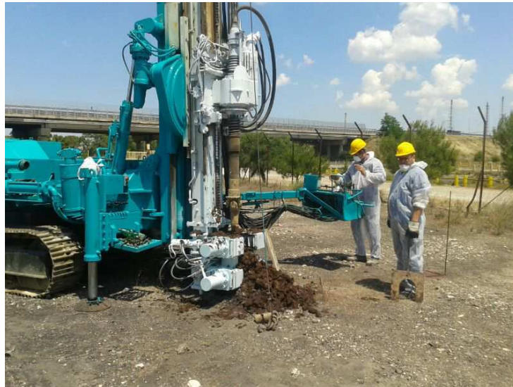
Figura 3.4: perforazioni per ricerca ordigni con carotiere a rotazione
