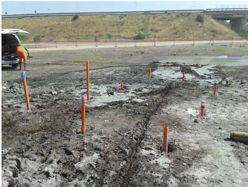
Figura 3.6: perforazioni per ricerca ordigni su “scatola” con diaframmi “CSM”
