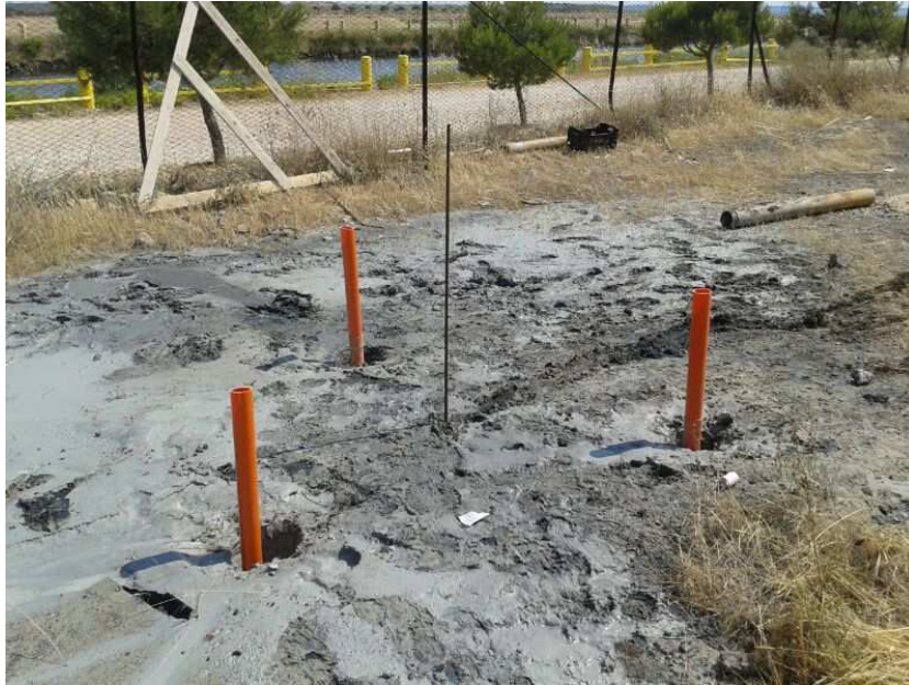
Figura 3.5: perforazioni per ricerca ordigni intorno ad un punto di sondaggio
