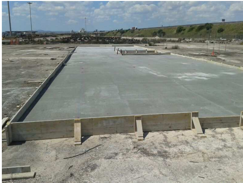
Figura 5.2: fasi di realizzazione della soletta di basamento delle baracche di cantiere
