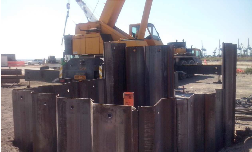
Figura 3.10: fasi di realizzazione della “scatola” con tecnica “PSP”
